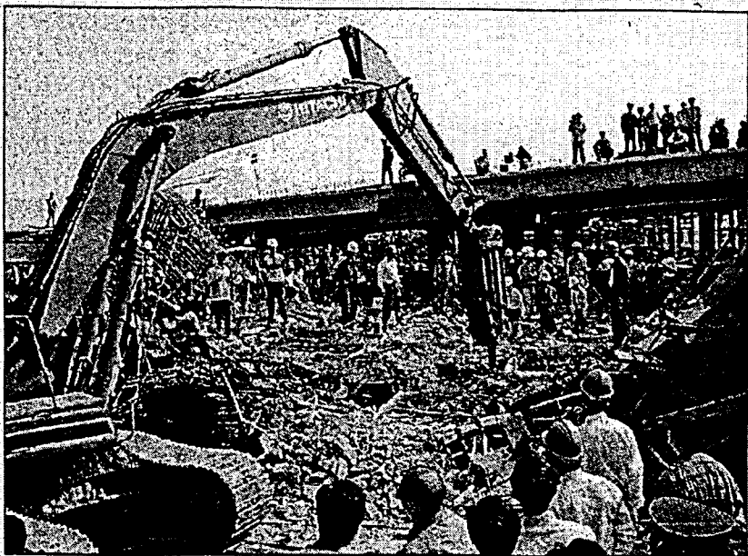
在廣州東圃高速公路塌橋意外現場，搶救隊調來液壓破碎機參加挖掘工作。
