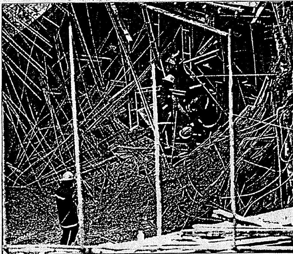
消防員在已塌下的地盤內，使用生命探測器，找尋還有沒有被困的地盤工友。
