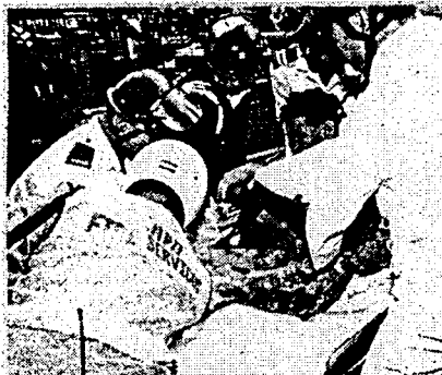
■西灣河地盤塌地台工人被救起送院。
