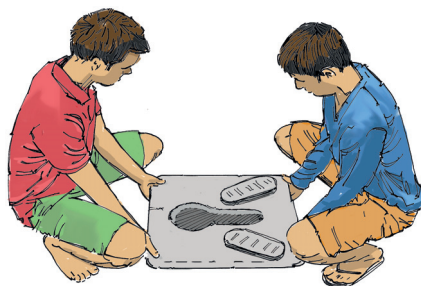
Figure 18. Lever une dalle Sanplat
