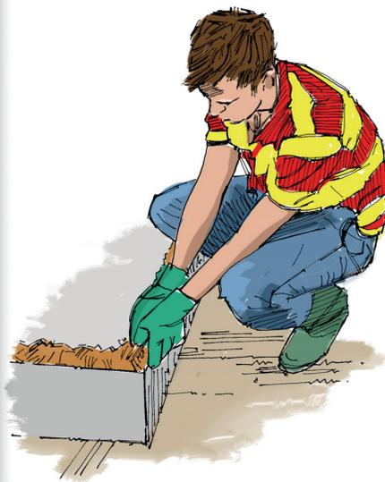
**Figure 21.** Construire un barrage en argile pour retenir l'eau qui sert à la maturation sur la dalle
