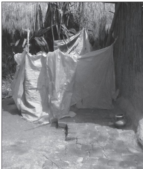
Figure 5.8. Le chemin en briques avec joints en terre et en sable, conduisant à un espace de toilette.
