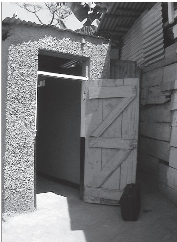
Figure 5.20. Pour les sanitaires, une porte à charnière double permet d'ouvrir vers l'extérieur et vers l'intérieur. Notez le symbole international d'accessibilité sur la porte.
