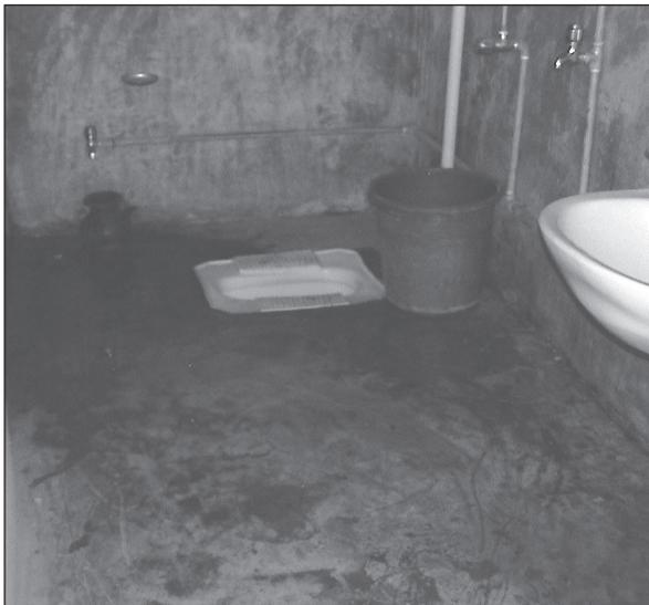
Figure 5.24. Salle d'eau et les sanitaires combinés. Notez les sanitaires dans le coin afin d'optimiser l'espace.
