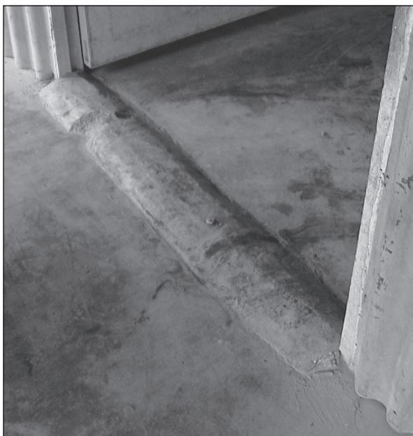
Figure 5.14. Seuil peu élevé de prévention des inondations, arrondi pour permettre l'accès en fauteuil roulant
