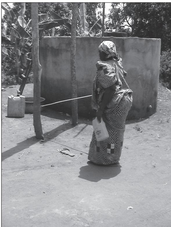
Figure 5.13. Deux poteaux fixes en bois servent de repères à une femme non voyante pour accéder au réservoir d'eau ou aux sanitaires, et pour en repartir. Pour un utilisateur malvoyant, les poteaux peuvent être peints ou marqués d'une couleur vive.
