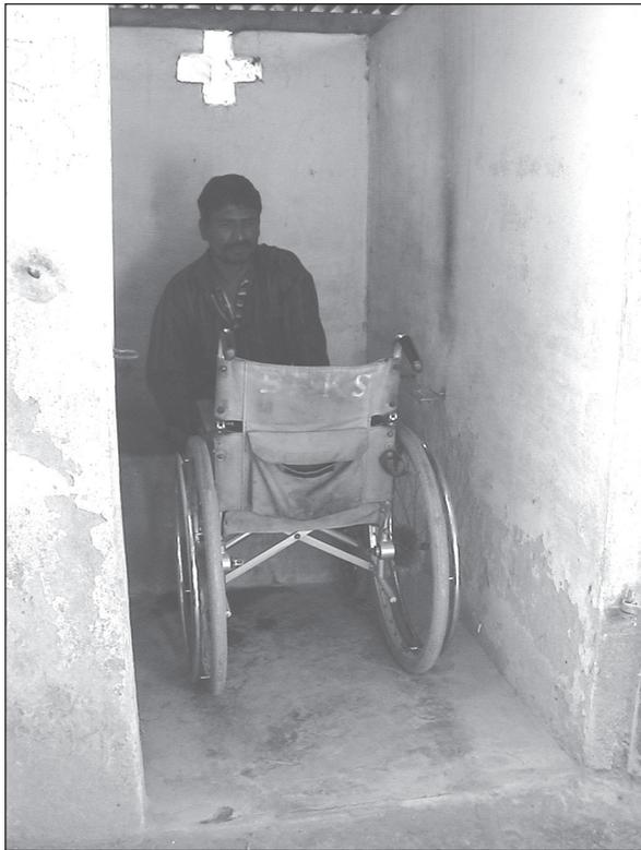
Figure 5.25. Des sanitaires suffisamment spacieux pour permettre à un utilisateur se déplaçant en fauteuil roulant d'y entrer, mais pas de faire demi-tour. L'utilisateur doit en ressortir en « marche arrière ».
