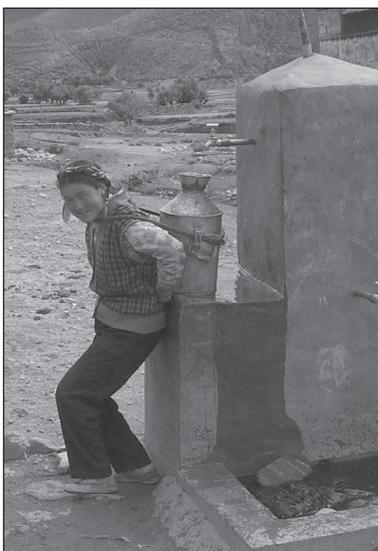
Figure 9.160. L'utilisation de robinets qui soulagent le dos. Notez la direction d'écoulement de l'eau dans le radier au niveau du sol.
