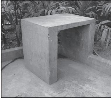
Figure 9.16. Une table de lavage en béton, située au bord du radier de la pompe manuelle.
