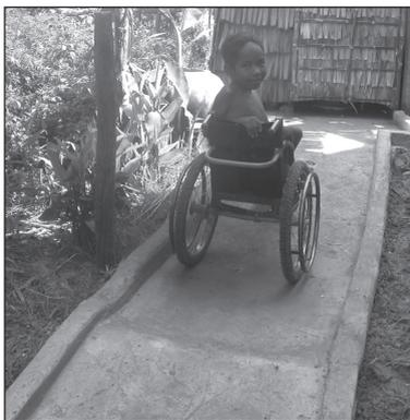
Figure 9.68. Une rampe en béton conduisant à l'espace de toilette.
