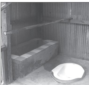
Figure 9.95. La barre d'appui en bois allant de la porte au mur arrière des sanitaires.
