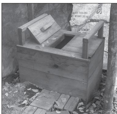
Figure 9.89. Un siège hygiénique en bois, dont le couvercle ôté permet de voir le trou des sanitaires.
