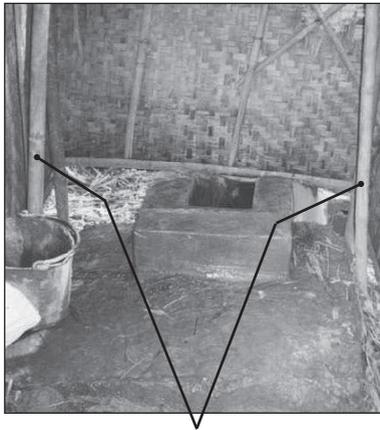
Figure 9.44. Des poteaux verticaux de soutien en bambou, de chaque côté de la dalle en béton (CRP).
