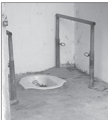
Figure 9.80. Les barres d'appui réglables.
