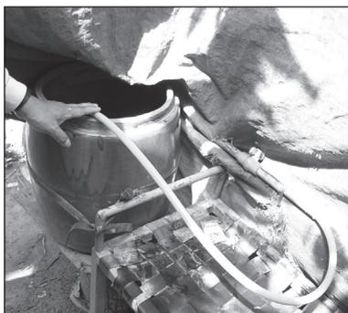
Figure 9.63. Un tuyau équipé d'un robinet pour remplir le réservoir de stockage de l'eau.
