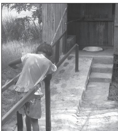
Figure 9.94. Les barres d'appui horizontales et parallèles permettent à un enfant se rendre de la maison aux sanitaires avec un minimum d'aide.
