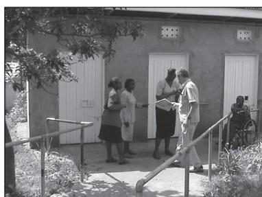
Figure 9.122. Une rampe en béton équipée d'une main courante de chaque côté pour accéder aux latrines.
