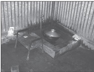
Figure 9.26. Un évier au niveau du sol avec paroi peu élevée en béton.
