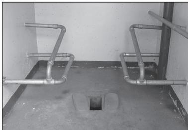
Figure 9.125. Des sanitaires « à la turque » avec des barres d'appui.
