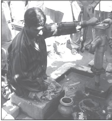
Figure 9.3. S'asseoir sur une plate-forme peu élevée en béton pour faire sa toilette.
