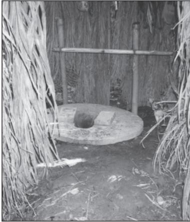
Figure 9.45. Une barre d'appui en bambou.
