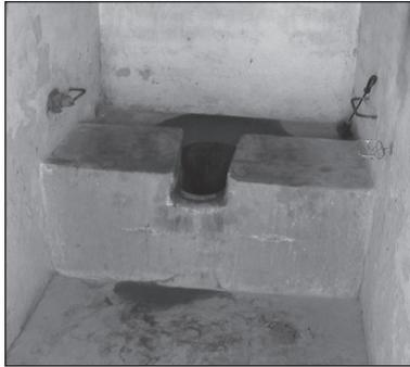
Figure 9.4. Une plate-forme sanitaire surélevée en briques avec une cuvette en PVC.
