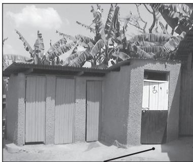
Figure 9.117. Des sanitaires accessibles aux fauteuils roulants, sur la droite. La flèche indique la rampe en béton.
