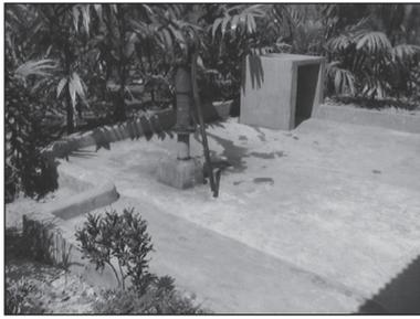
Figure 9.13. Une pompe manuelle avec large radier en béton pour faciliter l'accès en fauteuil roulant sur trois côtés.
