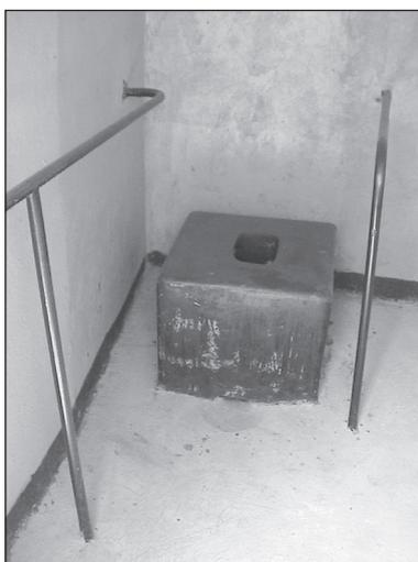
Figure 9.119. Un siège hygiénique en briques recouvertes d'une chape de ciment et peintes, avec main courante sur la gauche, allant de la porte au siège.
