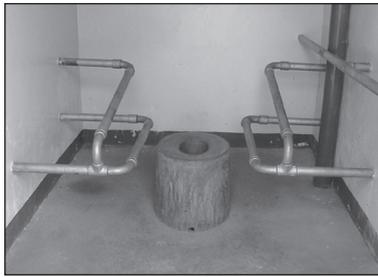
Figure 9.124. Un siège hygiénique surélevé équipé de barres d'appui.
