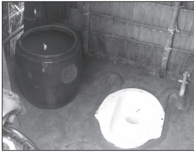
Figure 9.73. Une jarre d'eau à proximité de la cuvette des sanitaires. Notez les moulages en mortier de ciment pour bien positionner le fauteuil roulant.
