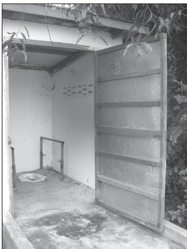
Figure 9.79. L'entrée lisse des sanitaires. Notez l'absence de plate-forme horizontale devant la porte, ce qui pose un problème.
