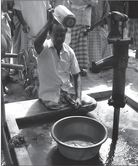
Figure 6.48. Une plate-forme d'assise peu élevée en béton.
