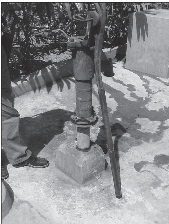
Figure 6.4. Une pompe manuelle avec radier indiquant le sens d'écoulement de l'eau loin de la pompe. Notez la poignée allongée pour démultiplier la force d'appui. (Etude de cas 9.3, page 164)
