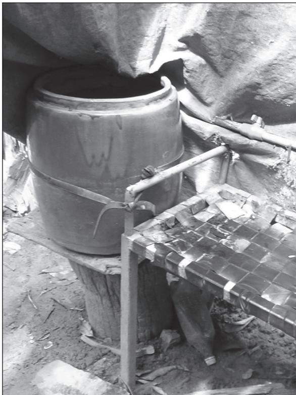
Figure 6.39. Le réservoir de stockage de l'eau dans un espace de toilette. Il est posé sur un support en bois et maintenu en place par une courroie en caoutchouc.
