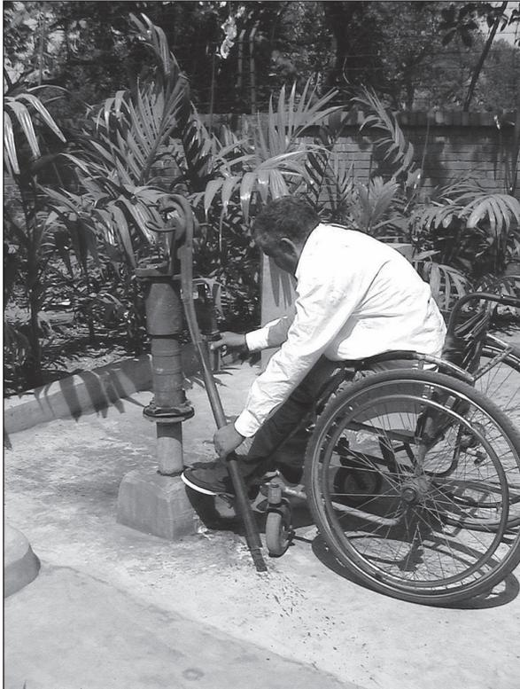
Figure 6.5. La même pompe manuelle, actionnée par un usager se déplaçant à l'aide d'un fauteuil roulant situé sur un radier au niveau du sol. (Etude de cas 9.3, page 164)
