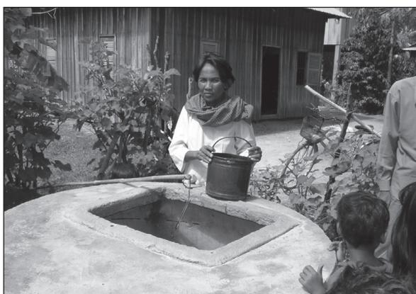
Figure 6.12. Une dalle en béton située au-dessus d'un puits offre une surface sur laquelle on peut poser un récipient.
