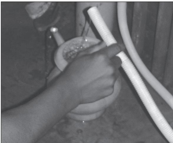
Figure 6.23. Un tuyau flexible raccordé à un robinet permet de verser l'eau dans un récipient d'une seule main. (Etude de cas 9.6, page 177)
