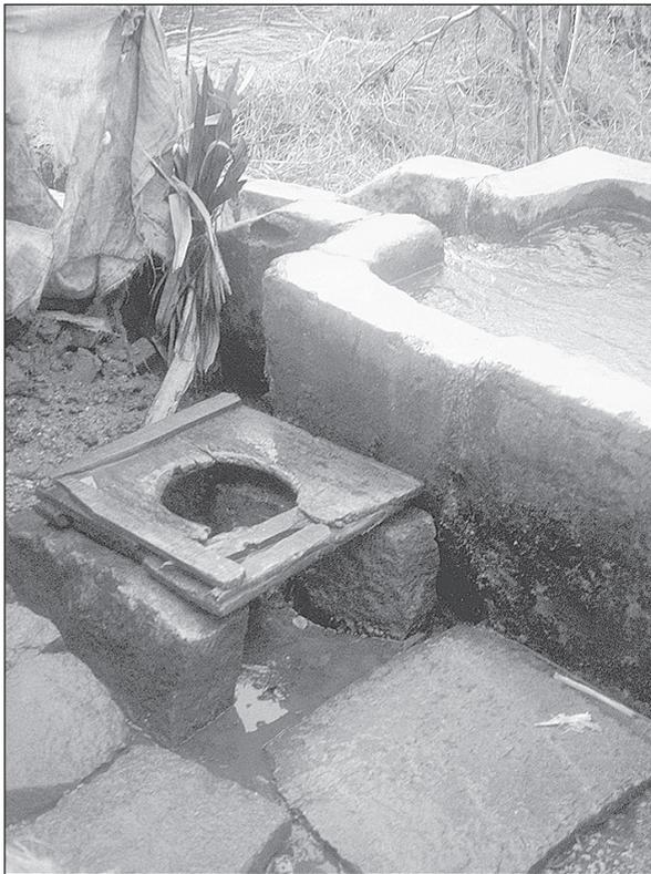
Figure 7.28. Un siège hygiénique en bois, soutenu par deux blocs de briques, positionné au-dessus de latrines à fosse. La fosse mesure plus de 2 m de profondeur afin d'éviter de contaminer la source d'eau. Sa position à proximité du bassin d'eau permet un accès facile à l'eau pour la toilette intime et le lavage des mains.
