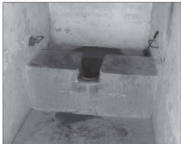
Figure 7.31. Une plate-forme en briques recouvertes de ciment, avec cuvette en PVC intégrée, disponible dans le commerce. Blocs d'assise à hauteur adéquate pour faciliter le transfert depuis un fauteuil roulant.
