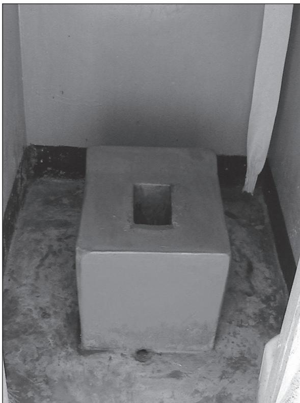
Figure 7.24. Un siège hygiénique en briques peintes, recouvertes de mortier de ciment. Dossier surélevé pour davantage de soutien.
