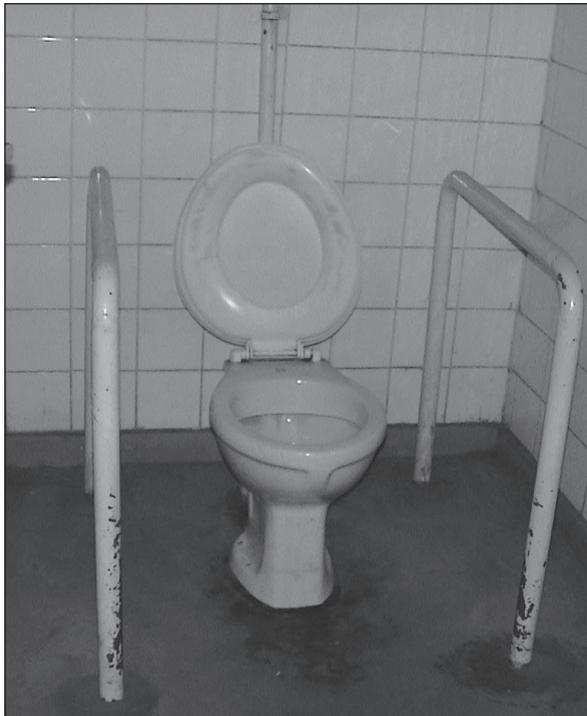
Figure 7.2. Une main courante fixée au sol de chaque côté de sanitaires « à la turque ». h : environ 30 cm (une large cuvette pour les sanitaires n'est pas recommandée).
