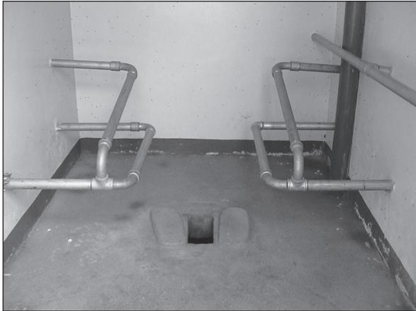
Figure 7.4. des barres horizontales et diagonales fixées aux parois latérales à différentes hauteurs. Notez la barre horizontale supplémentaire de l'avant vers l'arrière du mur, sur la droite. (Etude de cas 9.26, page 232)
