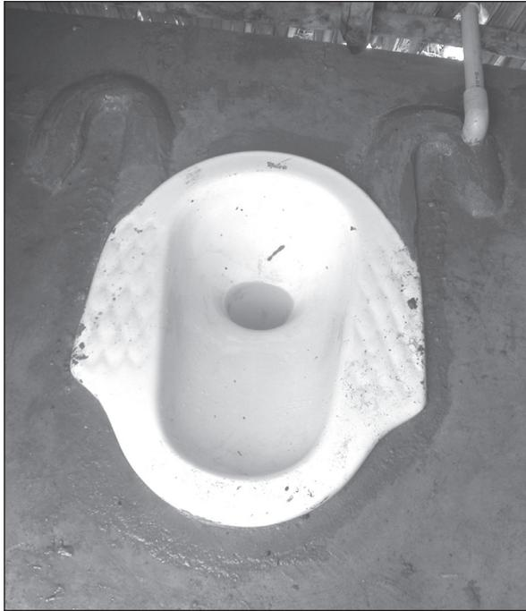
Figure 7.42. Des moules en mortier de ciment placés à côté de la cuvette des sanitaires, dans lesquels les roues du fauteuil roulant viennent s'emboîter pour un positionnement précis. (Etude de cas 9.15, page 201)
