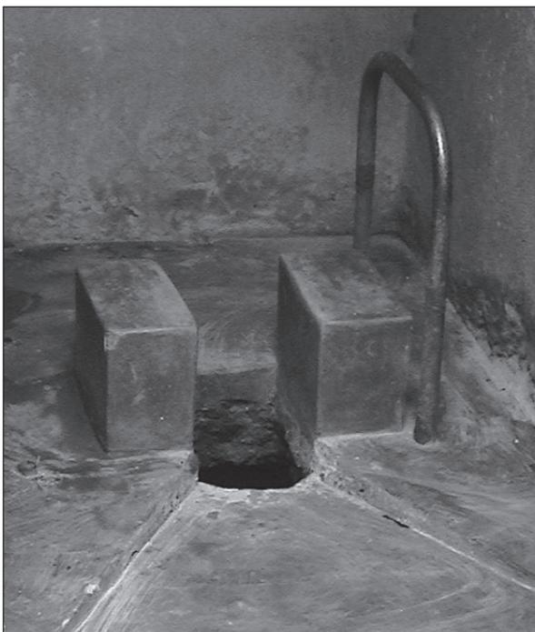
Figure 7.26. Deux blocs d'assise en briques recouvertes de ciment. Hauteur : 25 cm ; écartement : 14 cm. L'écartement facilite la toilette intime par rapport à un siège ordinaire.
