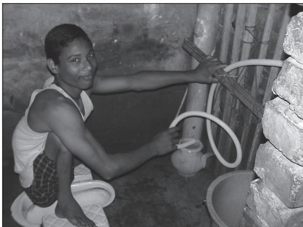
Figure 7.8. Une Barre horizontale en bois, fixée sur les tuyaux existants, devant les sanitaires. La hauteur de la barre (environ 70 cm) a été choisie par l'utilisateur. Aucun choix de distance pour la barre ; une barre plus proche aurait été plus confortable.
