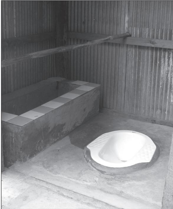
Figure 7.6. Une barre horizontale unique, en bois (h : environ 50 cm) allant de la porte au mur arrière, utilisée comme soutien pour entrer dans les sanitaires. Trop haute pour qu'un enfant s'y appuie lorsqu'il s'accroupit.
