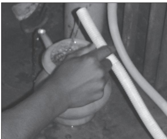
Figure 7.54. Un tuyau flexible raccordé à un robinet permet à l'utilisateur de remplir d'eau un récipient en n'utilisant qu'une seule main. (Etude de cas 9.6, page 177)
