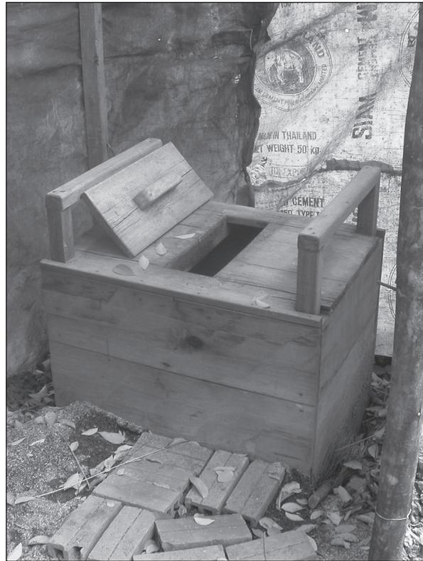
Figure 7.29. Un siège hygiénique en bois, en forme de boîte, au-dessus de latrines à fosse. Un couvercle empêche l'apparition de mouches et de mauvaises odeurs lorsque les sanitaires ne sont pas utilisés.
