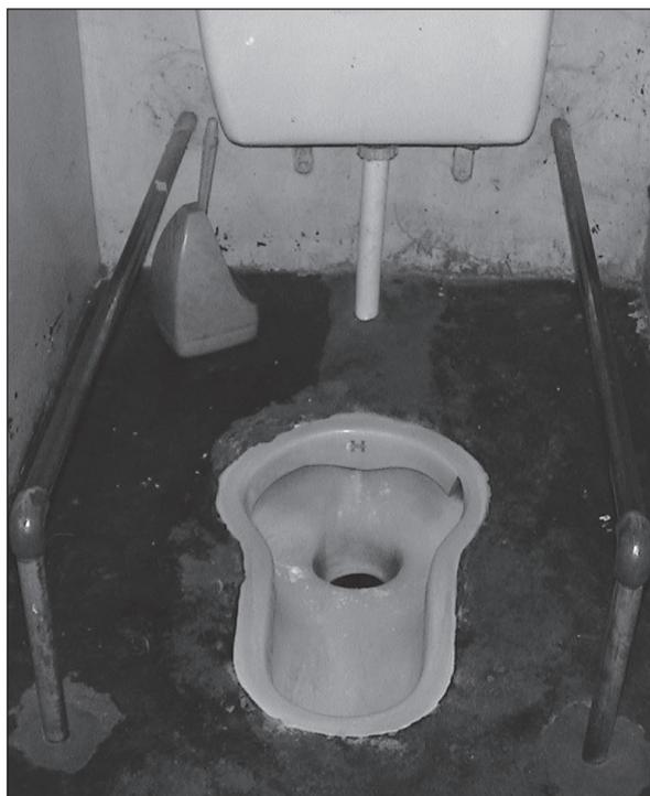
Figure 7.1. Une main courante fixée au sol de chaque côté de sanitaires « à la turque ». h : environ 30 cm (une large cuvette pour les sanitaires n'est pas recommandée).
