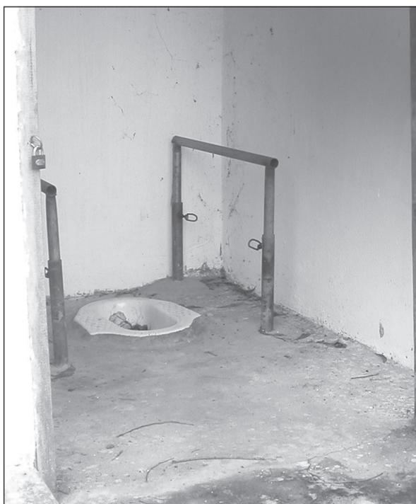
Figure 7.17. Des barres d'appui à hauteur réglable, adaptées à un enfant qui grandit.
