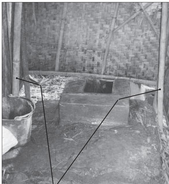
Figure 7.11. Deux poteaux verticaux de soutien en bambou, de chaque côté des latrines.
