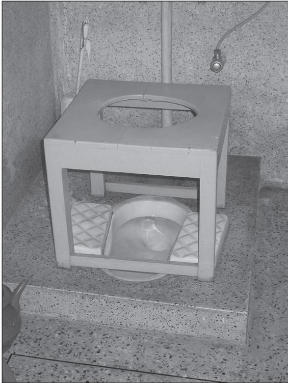
Figure 7.36. Un tabouret de toilette utilisé au-dessus des sanitaires « à la turque ». Une fois peint, le bois résiste à l'humidité. Pas de système contre les éclaboussures.
