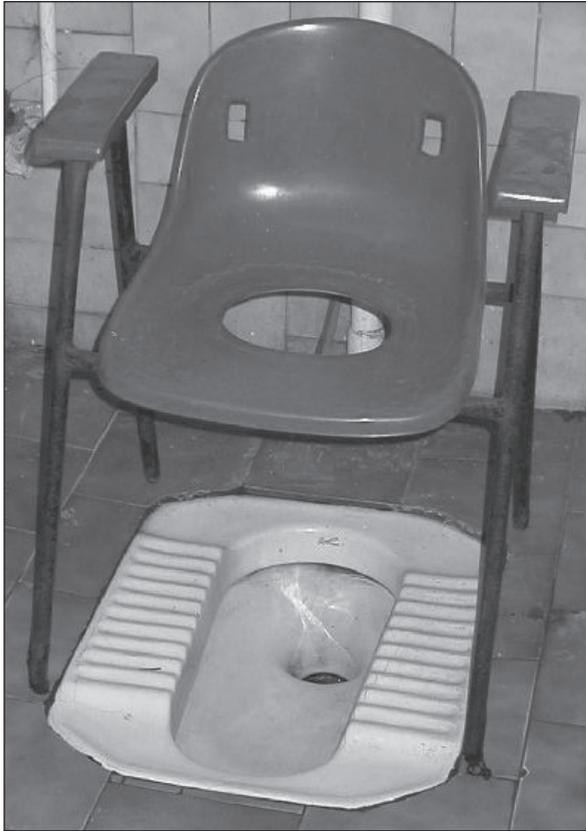
Figure 7.34. Un siège hygiénique en plastique moulé : durable, facile à nettoyer, hygiénique. Coût élevé. Trou assez reculé sur le siège. Pas.
